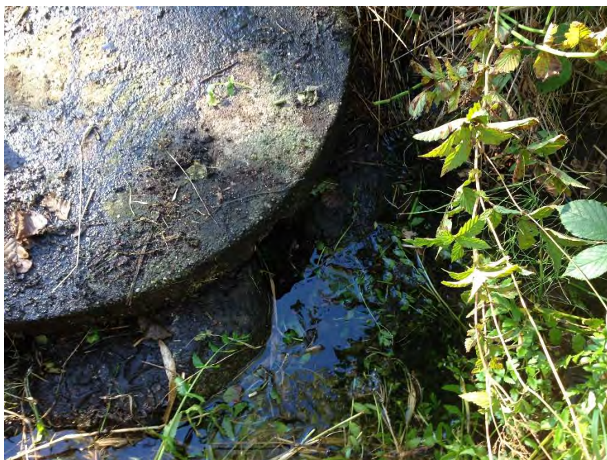
Figur 3. Stenmuret brønd i kanten af Vandløb fra Skovhoved Skov. Vandet ledes ind fra vandløbet, ind i et pvc-ribberør inden det føres under skovvejen til en grøft syd for skovvejen.
