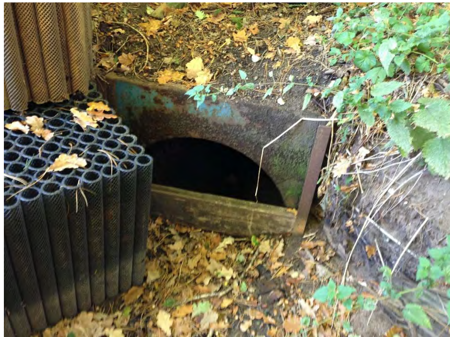
Figur 10. Indløb til rørlagt strækning bag lagerbygning ved Kongeåens Dambrug.
